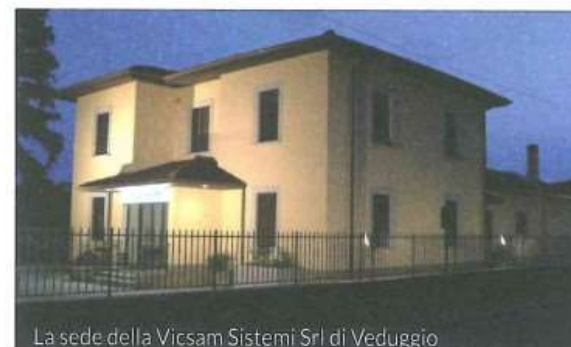
La sede della Vicsam Sistemi Srl di Veduggio
